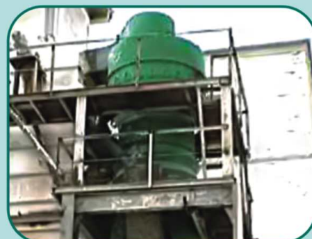
УГЛОВСКИЙ ИЗВЕШТКОВЫЙ КОМБИНАТ, 2007 г. КОМБИНИРОВАННЫЙ КЛАССИФИКАТОР 30т/ч, известь
